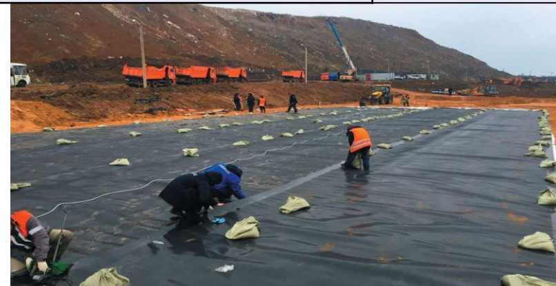
Монтаж противофильтрационного экрана из геомембраны
